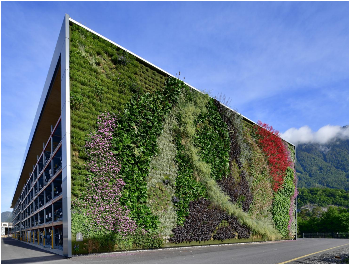
BuGG-Fassadenbegrünung des Jahres 2022: Vertikaler Garten der BLS Werkstätten in Bönigen
